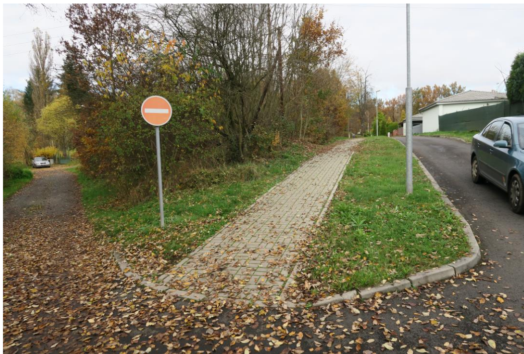
ZOV Příloha č. 1,2 – nutné zkrácení oblouku při ulici Pod školkou a Podlesí, vybourání obruby, dlažby a trávniku, posun značky, zásyp provizorním R materiálem
